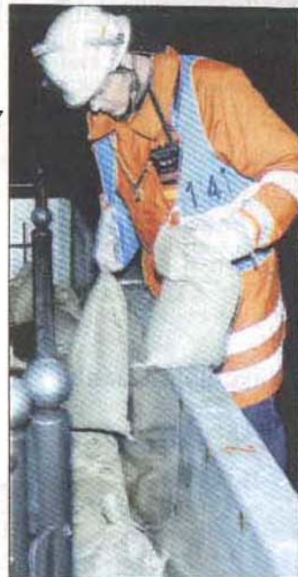
Wolfach spielt eine besondere Rolle: Hier ist für die Experten im Regierungspräsidium Hochwasserschutz nur durch Objektschutz möglich. Foto: Archiv
